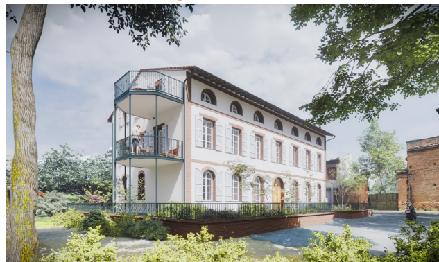
LOGEMENTS INDIVIDUELS, LA MAGNANERIE - POMPERTUZAT (31)
