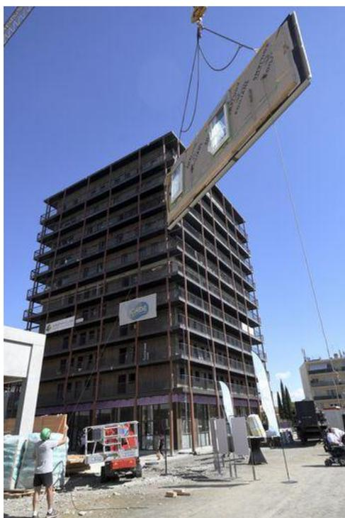
Les murs en bois massif sont assemblés comme en un jeu géant de construction dans la tour de 10 étages et les immeubles de Wood Art. DDM - DDM XAVIER DE FENOYL
